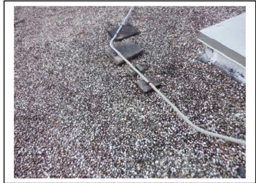
Conduit on Roof
